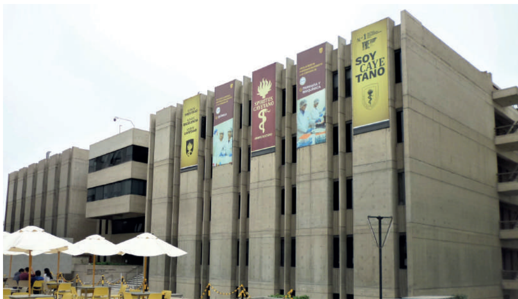
Figura 3. El edificio del LID construido hasta el cuarto piso.
