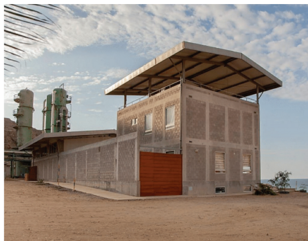
Figura 1. Vista de la infraestructura del CITEacuícola UPCH, parte de la Sede Norte del CIDIS, en El Alto, Talara, Piura. Se observa el exterior del área administrativa, de docencia y de los laboratorios.
